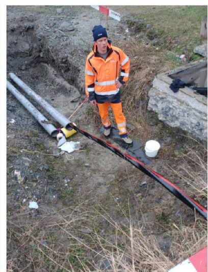
MS Kabelzug mit Kabelfett
