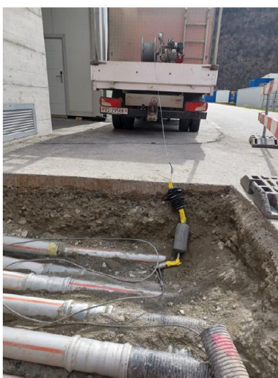
Verlegen von Einzugsseil
